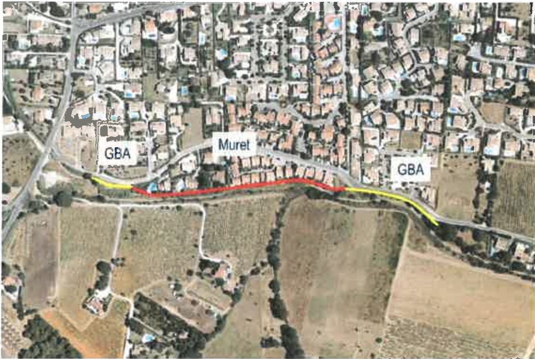
Fig. 6. Type d'ouvrage de protection rive gauche sur la commune de Bormes (1/2)
