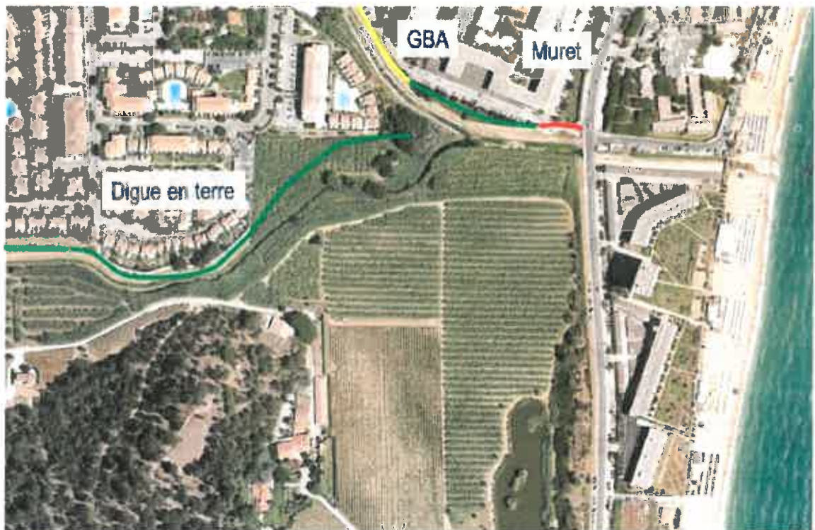
Fig. 9. Type d'ouvrage de protection rive gauche sur la commune du Lavandou (2/2)
