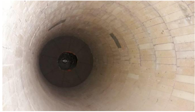
Figure 26. Vue de l'intérieur de la chaudière après briquetage
