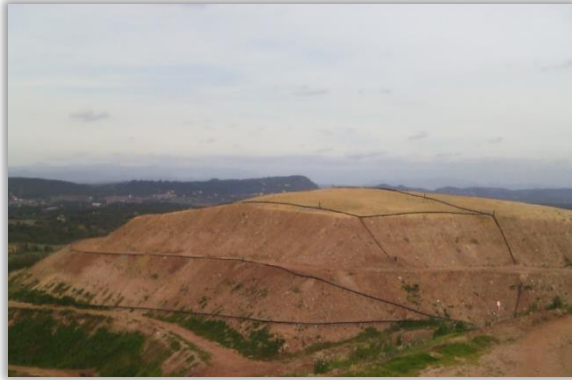
Figure 8. Photographie d'un réseau de captage du biogaz
