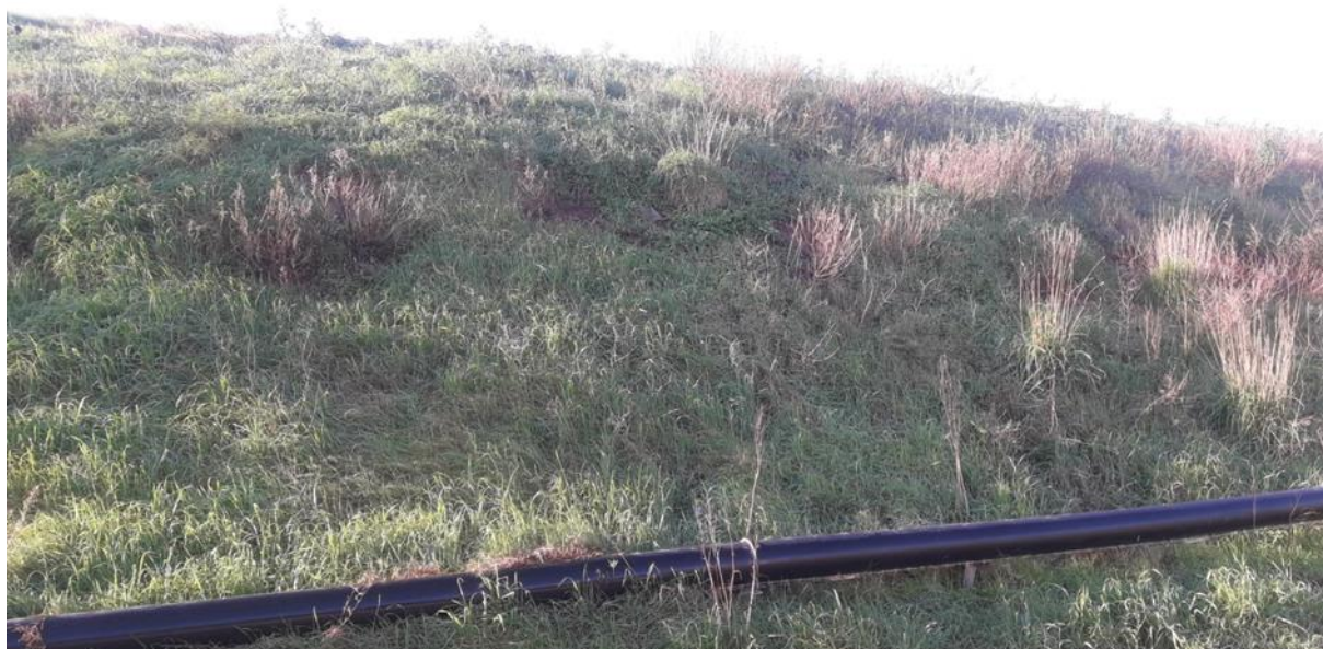
Figure 66. Vue de l'évolution de l'ensemencement sur le talus site 2
