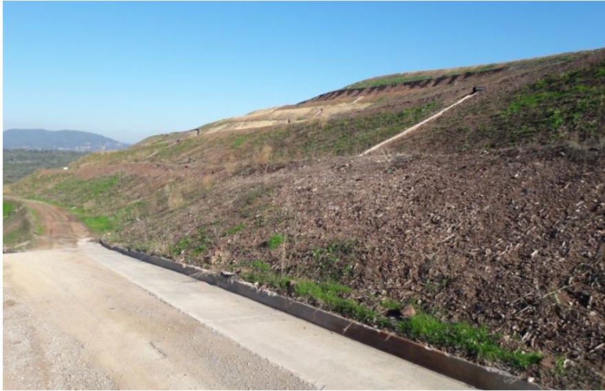
Figure 21. Vue sur les talus du site 2 et 3 - mars 2018
